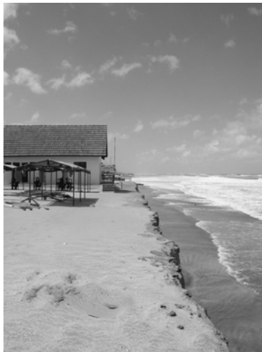
Fig. 10. A) En 1980 un temporal destruyó una edificación gastronómica. B) 20 años después nuevas construcciones tuvieron el mismo riesgo.
