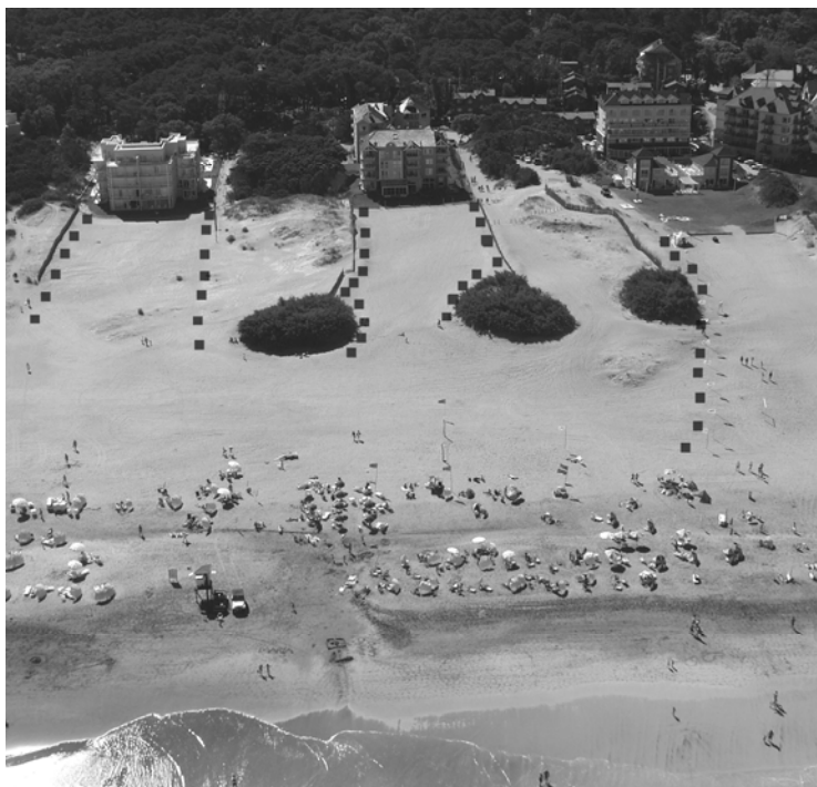
Fig.11. Vista aérea de Apart Hoteles sobre el frente marítimo de Cariló. (Enero de 2006). Se observa en punteado las aperturas realizadas del médano.
