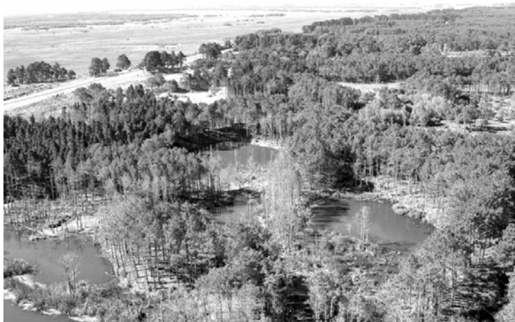
Fig. 5. Vista aérea del sistema de lagunas de tratamiento de líquidos cloacales en la Localidad de Pinamar (enero de 2006).
