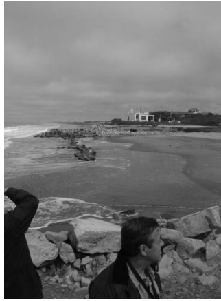
Fig. 2. A) En 1987, una hilera de tetrápodos prometía evitar el retroceso de los médanos litorales. B) 20 años después los tetrápodos yacían hundidos en la playa, y transversales a los compartimentos logrados entre espigones en T.
